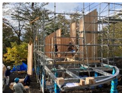
DLT 施工の様子
