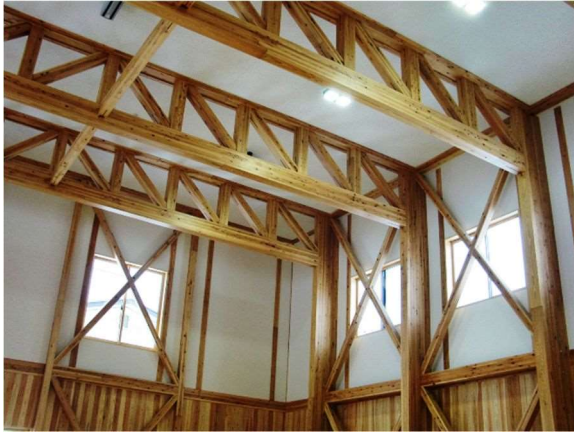
木造公共施設の整備
