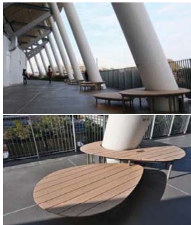
5階の外周ベンチは九州全域のSGEC木材が使用
